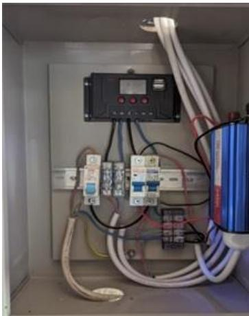
**Gambar 8.** Pemasangan dan penempatan SCC pada panel kontrol
